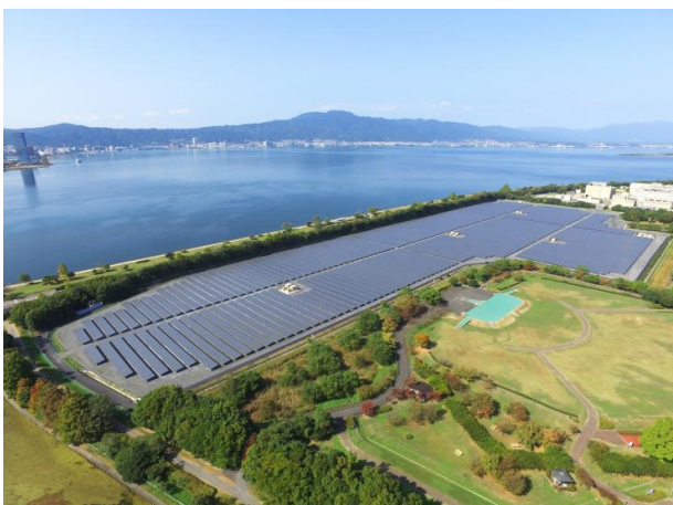
Une centrale solaire de 8,5 MW sur l'île de Yabasekihanto
